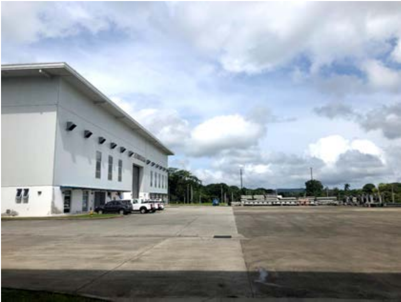
Vista al edificio de mantenimiento
