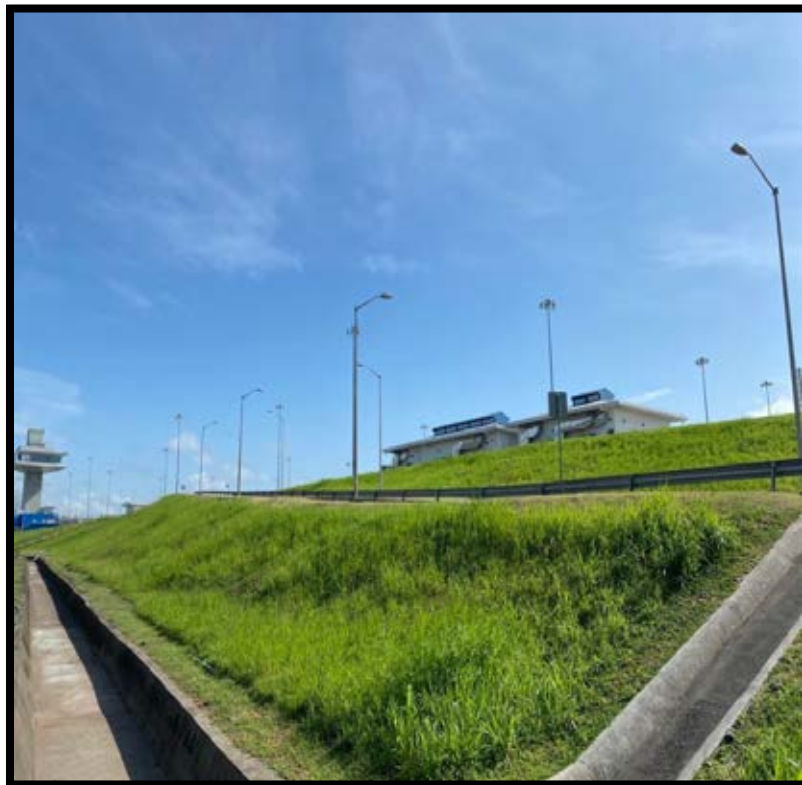
Foto 4. Mantenimiento a talud en la cámara media lado continente (control de maleza y fertilización).
