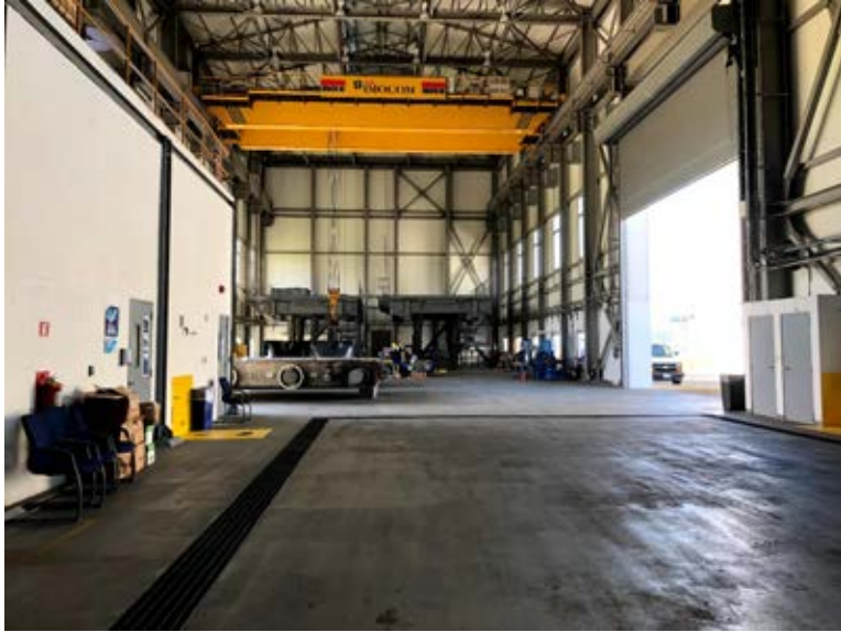
Taller de mantenimiento
