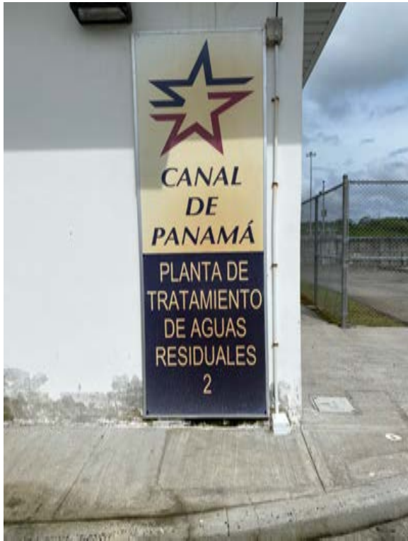
Edificio de PTAR Isla
