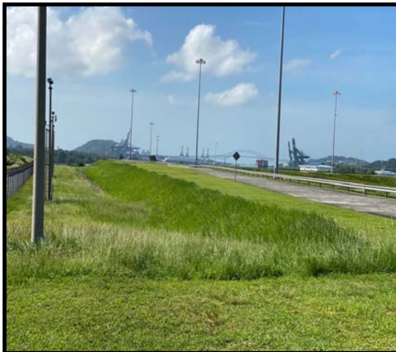
Foto 5. Mantenimiento a talud en el lado Isla (control de vegetación) .
