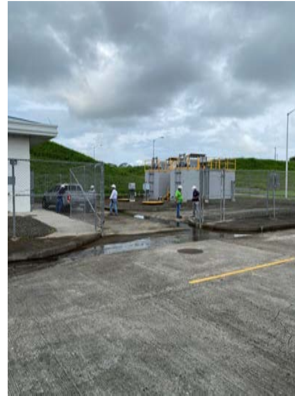
Vista de la PTAR
