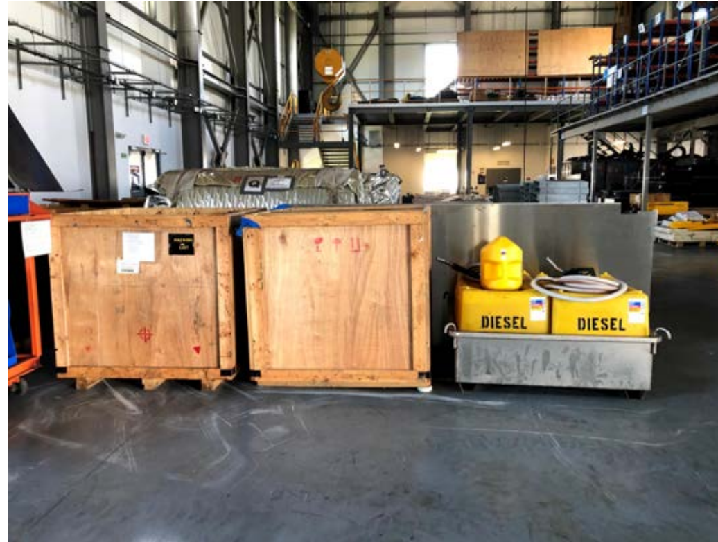
Almacenamiento de materiales peligrosos con contención secundaria
