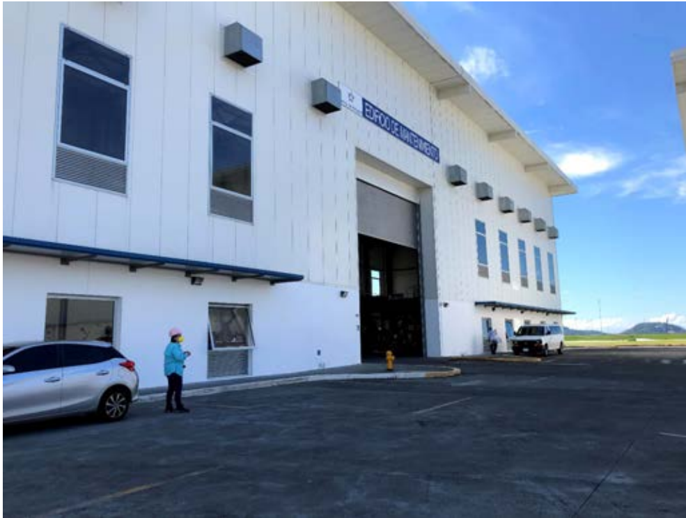
Entrada al edificio de mantenimiento
