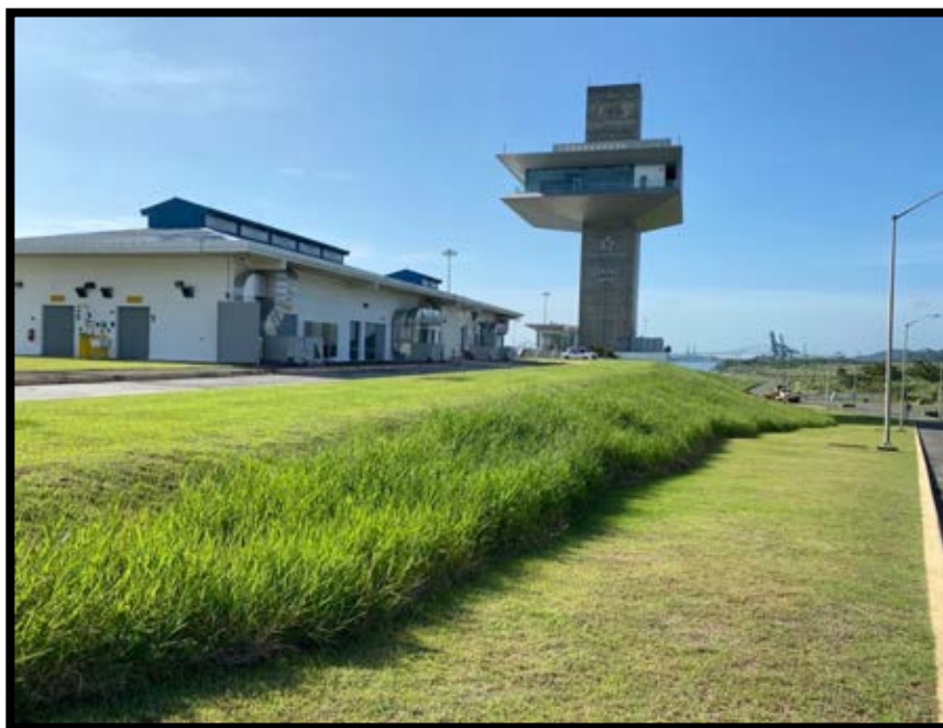
Foto 2. Mantenimiento a talud en la cámara alta lado continente (control de maleza y fertilización).
