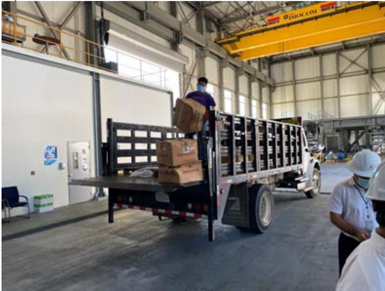
Descarga de materiales
